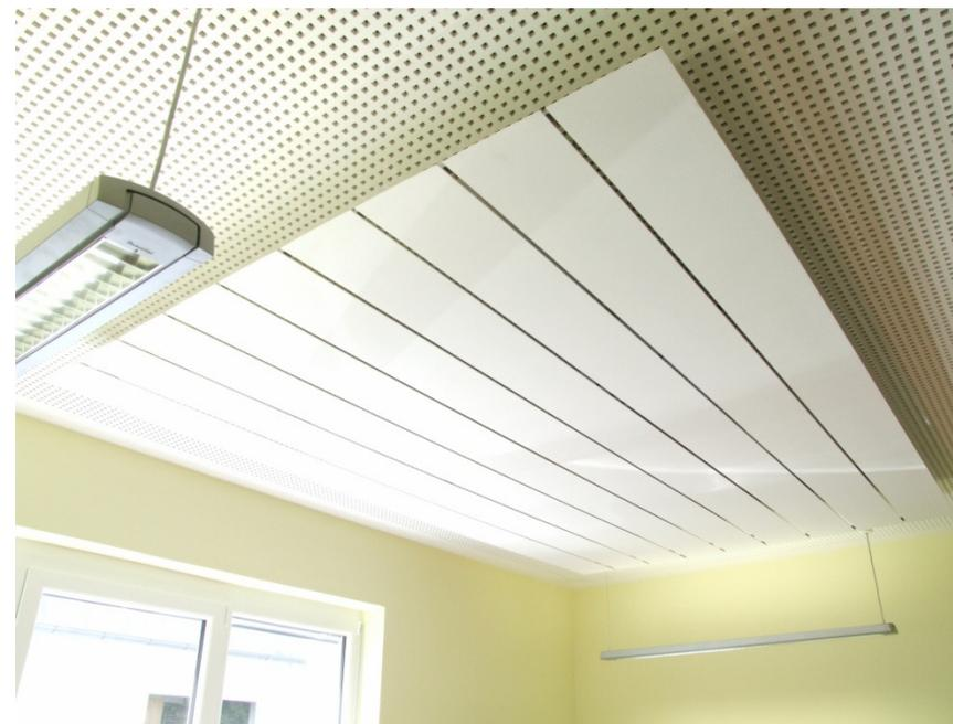
Расчетная мощность охлаждения согласно DIN EN 14240 (10K) **139 В/м²**
