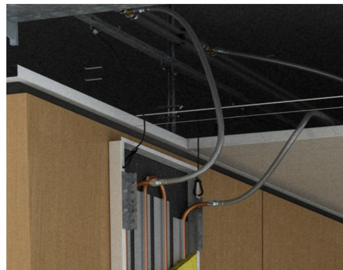
Расчетная мощность охлаждения согласно DIN EN 14240 (10K) **97 В/м²**
